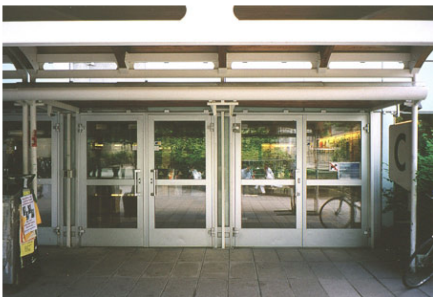
Huvudentré C på lågdelen norrfasad. Aluminiumdörrar med raka stålhandtag.
