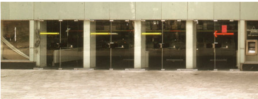
Huvudentré A från tidigt 70-tal, med entrédörrar helt i glas. Denna eleganta lösning fungerade tyvärr inte och dörrarna utbyttes tidigt mot aluminiumdörrar. Foto: Per Bergström
