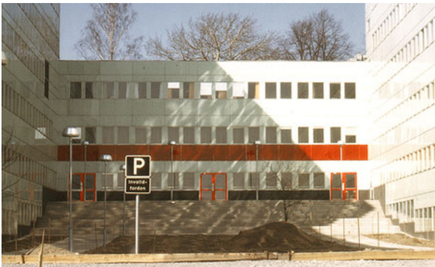
Gården mellan hus A och B, tidigt 70-tal. Dörrpartierna är i sin helhet lackerade i kodfärg. Denna målning genomfördes sannolikt bara på hus A och finns inte kvar längre. Foto: Per Bergström
